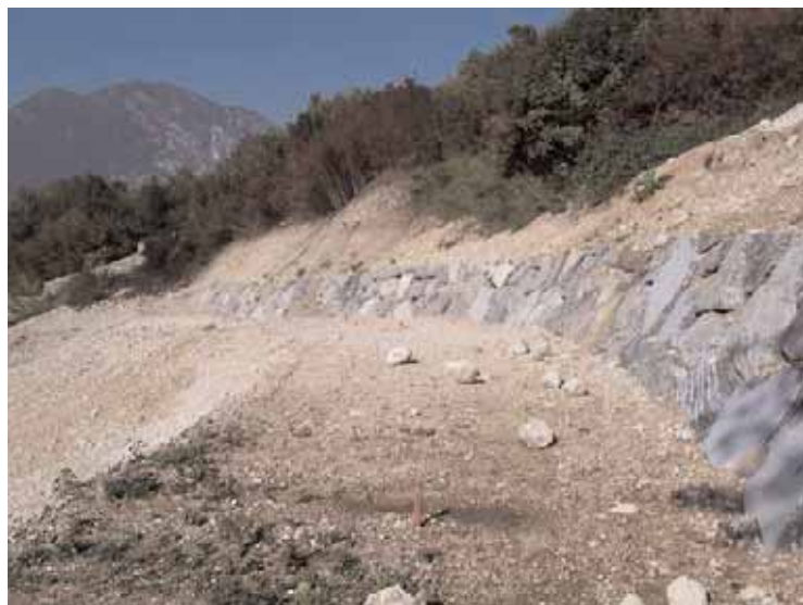
Lavori di sbancamento in corso con formazione di muri tipo scogliera - 11/09/2005
