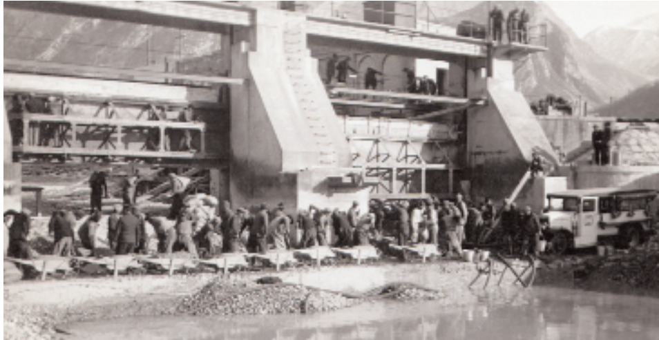
1908: Lavori nella presa di Ospedaletto
